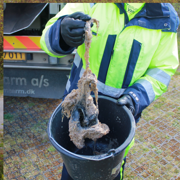
»Der er tale om en god gang kludeværk,« lyder det fra Egon Brunbjerg, da pumpestationen ved Lalandia bliver ordnet og rengjort.
