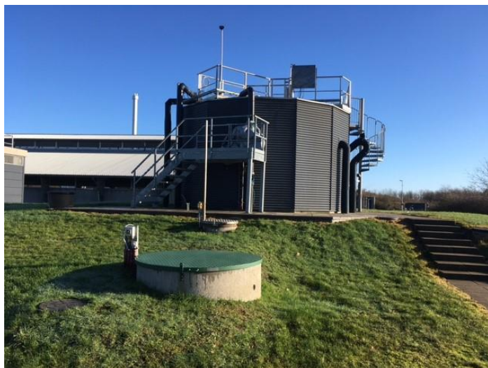
Forbehandlingstank til Anitamox
