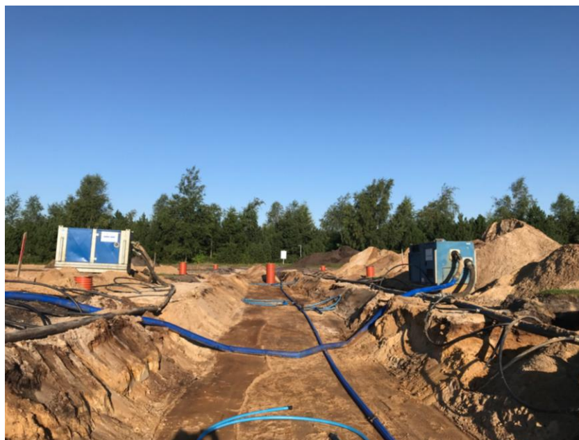
Sugespidsanlæg på begge sider af udgravningen i Lalandia. Kloakken er kommet i jorden og der etableres vandforsyning.
