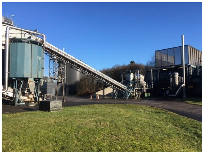
Forbehandlingstank til Anitamox
