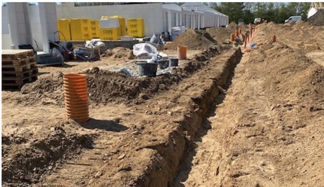
Etablering af skelbrønde ved byggemodning i Billund syd.
