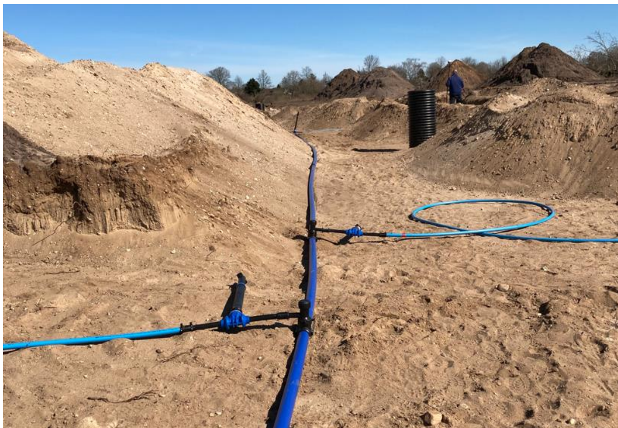
Ny Ø63 hovedvandleddning og stikledning ved byggemodning i Billund syd
