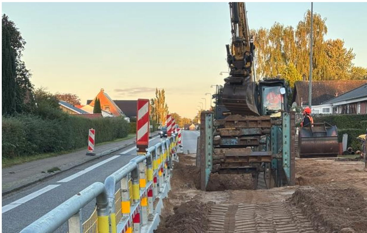
Arbejde med gravekasse og delvis afspærring af Østergade i Vorbasse
